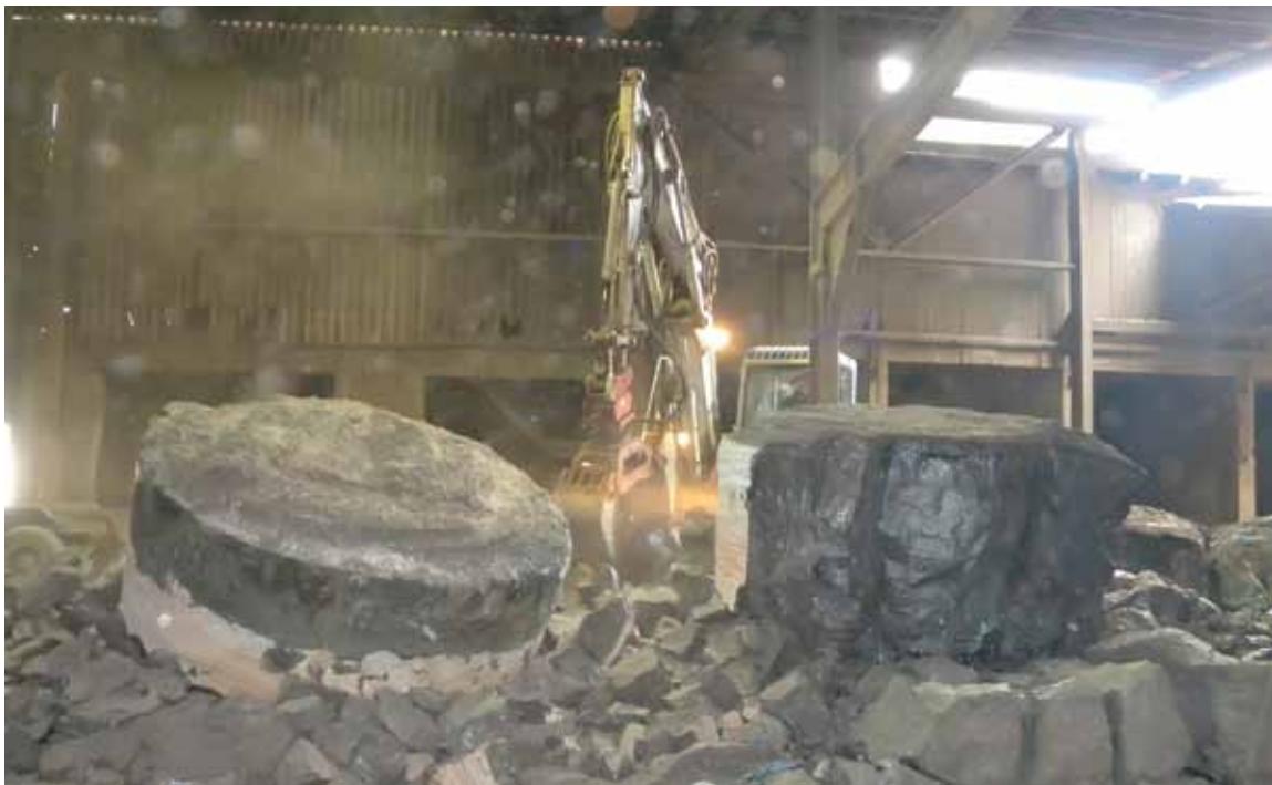
Resim 1. Merkez Demiryolu İstasyonu İnşaatı
