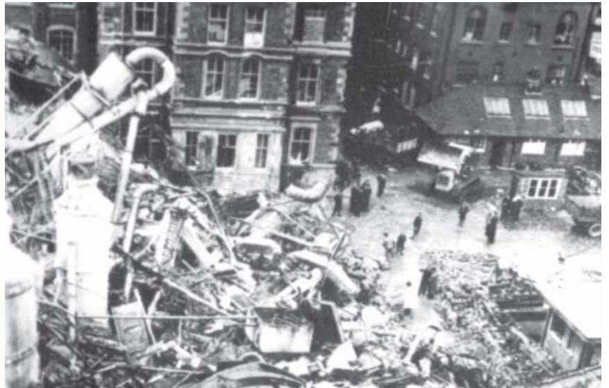
Resim 1. Bir Un Değirmeni'ndeki Patlama Sonrası Görüntü
