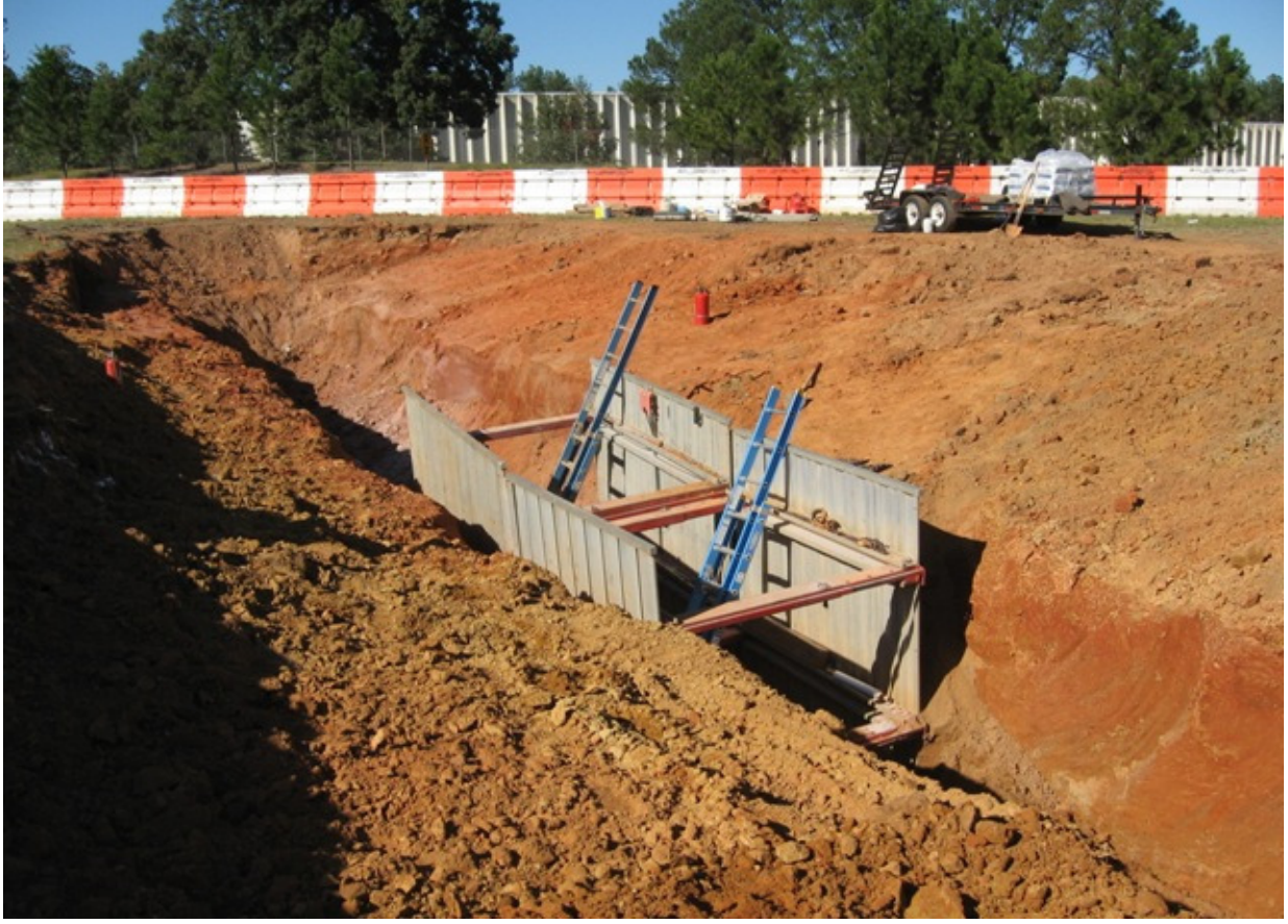
Şekil 25: Kalkalı dar kesitli kazı 26
