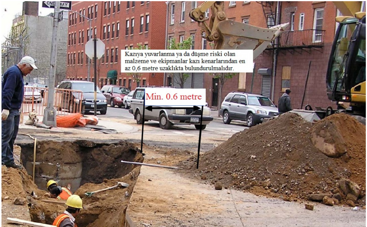
Şekil 32: Hafriyat yığını dar kesitli kazıdan yeterli uzaklıkta tutulmalıdır 28 .
