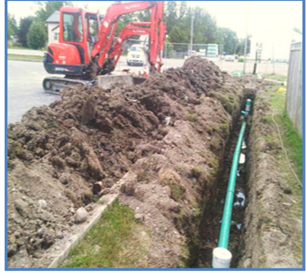
Şekil 11,12: Yığınlar kazıdan uzakta olmalıdır 16,17 .
