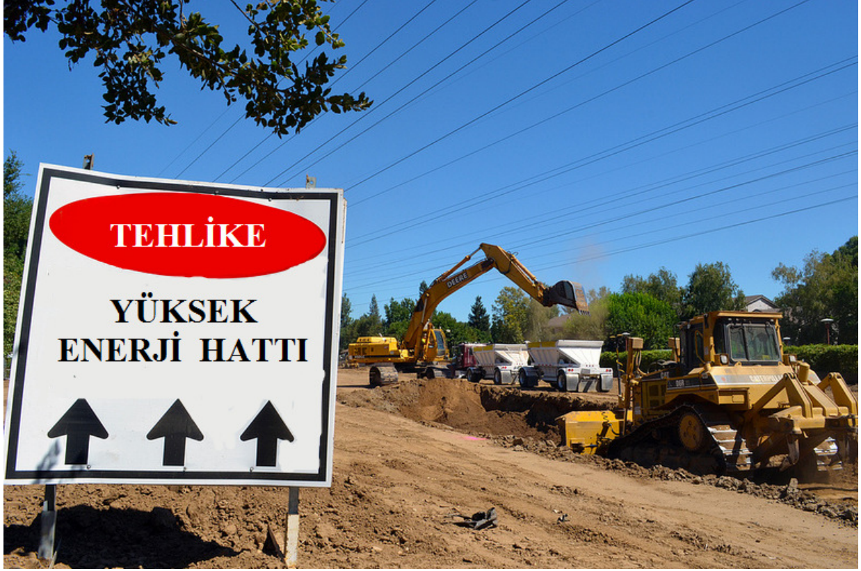
Şekil 35: Üstten geçen enerji hatları kazı araçları için tehlike oluşturmaktadır 31 .
