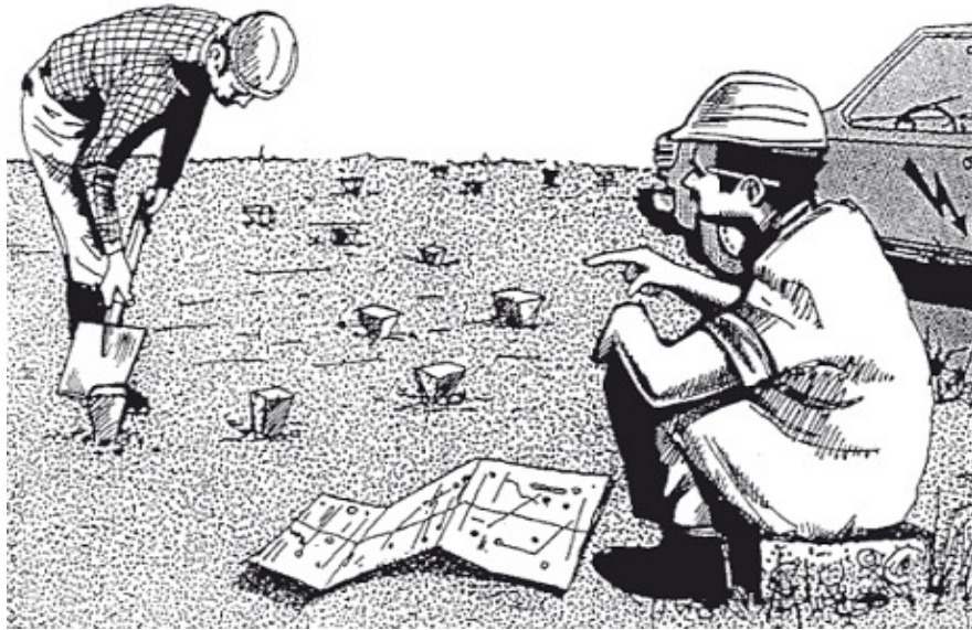
Şekil 34: Kazıdan önce yeraltı hizmetlerinin yerleri tespit edilmelidir 29 .
