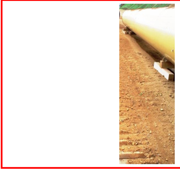
Şekil 11,12: Yığınlar kazıdan uzakta olmalıdır 16,17 .
