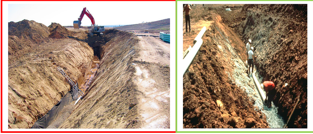
Şekil 20,21:Eğimli dar kesitli kazı 23,24
